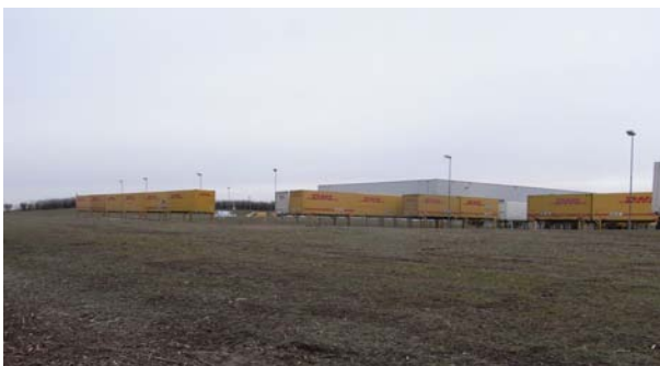
Abb. 1: Blick von Norden auf die Gewerbehallen
